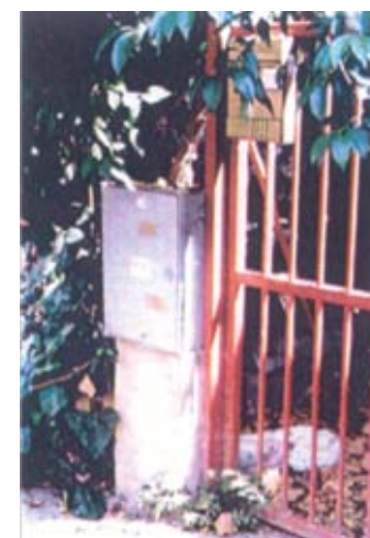
Τοποθέτηση των μετρητών στη ρυμοτομική γραμμή
