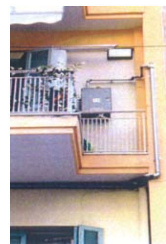
Τοποθέτηση των μετρητών στα μπαλκόνια
