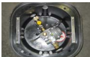
Ρυθμιστής αστικού πελάτη υπόγειου τύπου
