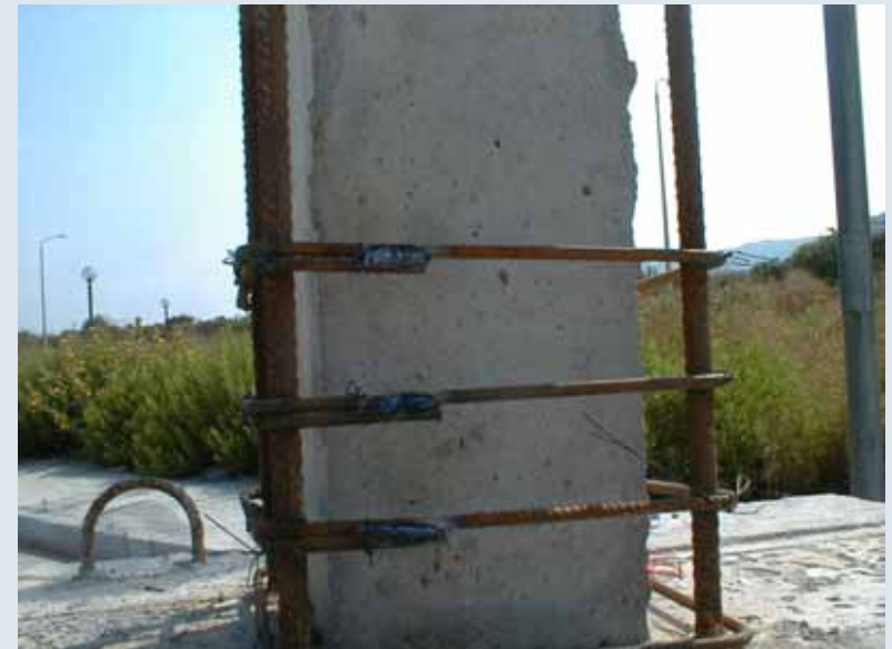
Ηλεκτροσυγκόλληση Άκρων Συνδετήρων Μανδύα
