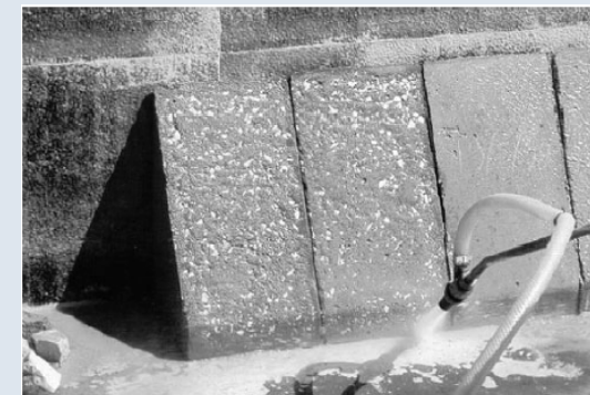
Εκτράχυνση με Αμμοβολή
