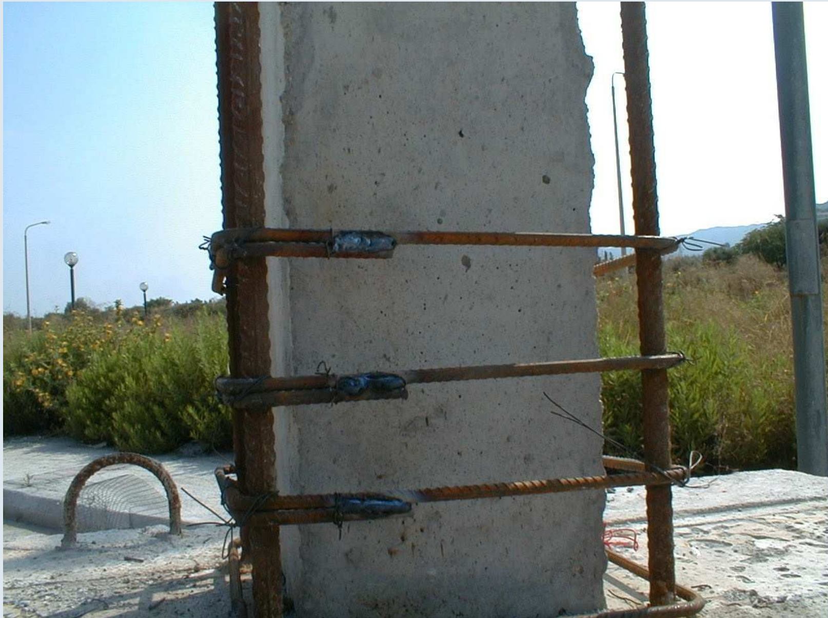
Ηλεκτροσυγκόλληση Άκρων Συνδετήρων Μανδύα 18
